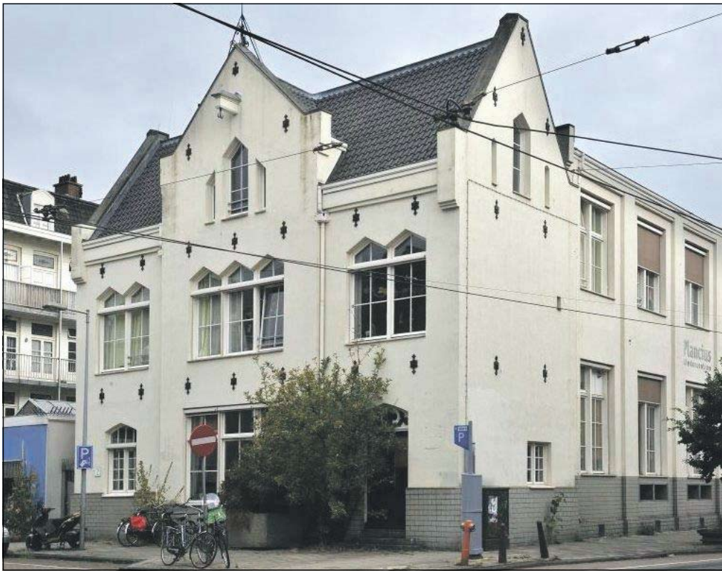
Het schoolgebouw uit 1882 aan Planciusstraat 20. Eerst ‘Armenschool nr 8’, later ‘gebouw de Arend’, en nu kinderdagverblijf Plancius.
