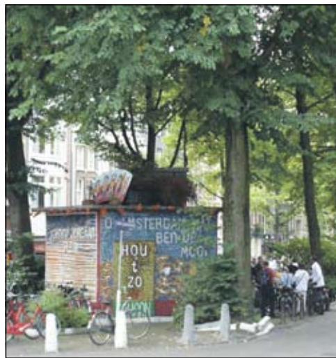
Het met sloop bedreigde transformatorhuisje aan het Johnny Jordaanplein.
