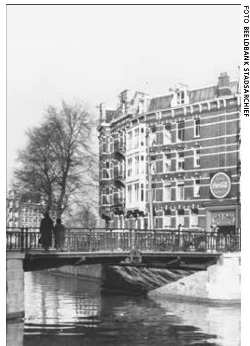
Bullebakbrug voor de renovatie
